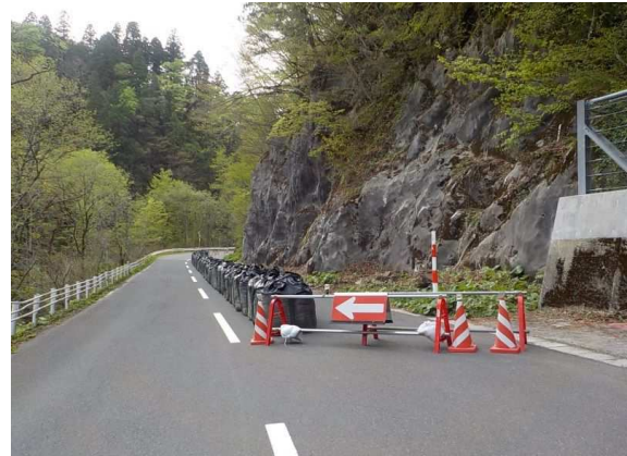
応急処理工(国道105号)
