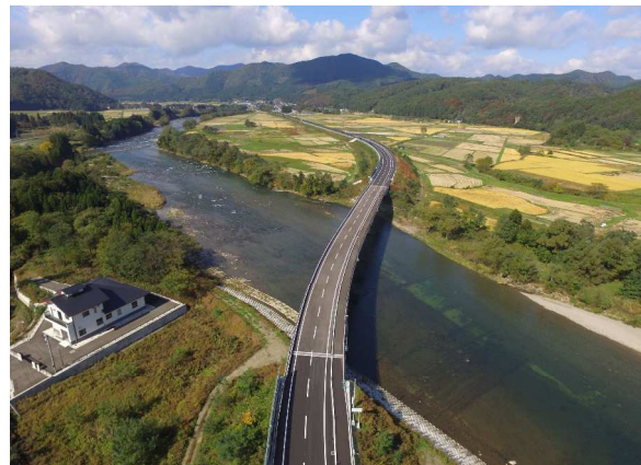
国道103号 鹿角市・大館市 葛原バイパス (H28. 10. 27完成供用)
