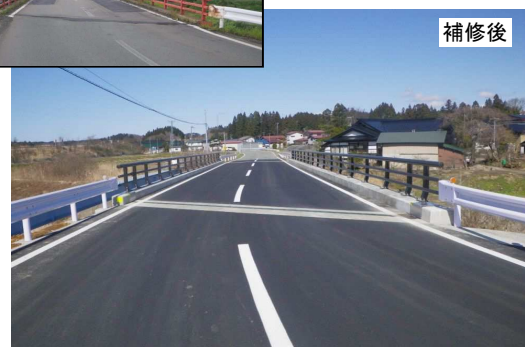
橋梁補修工((主)秋田岩見船岡線 八田大橋)
