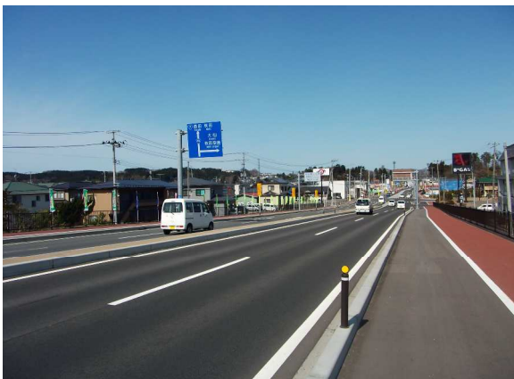
国道107号 由利本荘市 本荘道路 (H28. 11. 29一部供用)
