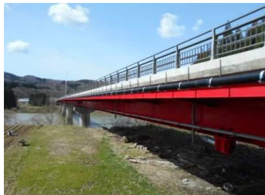
主桁塗装、耐震補強
